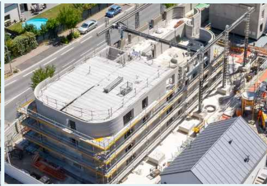
*자료 : PERI 3D Construction 사
