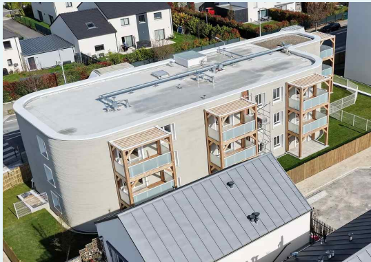
*자료 : PERI 3D Construction 사
